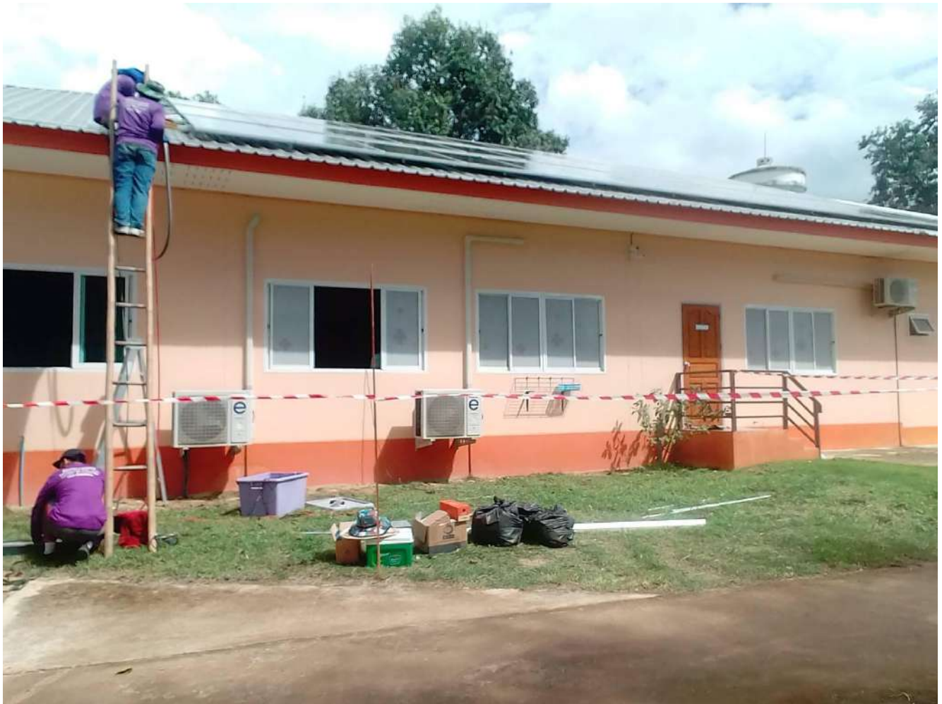
รูปภาพแผงโซลาร์เซลล์บนหลังคา
